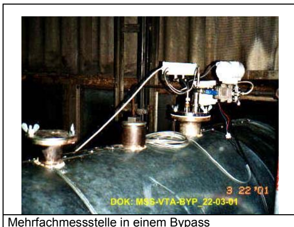
Mehrfachmessstelle in einem Bypass
